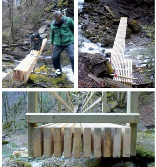
einfachere und kostengünstige Lösung ausgetüftelt. Es konnte eine natürliche Schneise im Wald gefunden werden, wo von der Parzelle Scharfmoos aus ein Stahlseil gespannt und das Holz innerhalb eines halben Tages einzeln am Seil bis zum Fallbach hinunter gelassen werden konnte. Die Einzelteile der Brücke wurden von unseren Bauhof-Mitarbeitern direkt vor Ort auf den vorbereiteten Metall-Lagern zusammgebaut. Fotos und Videos dazu finden Sie auf unserer Homepage.
